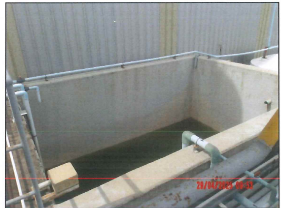
บ่อพักน้ำทิ้งฉุกเฉินขนาด 111 ลูกบาศก์เมตร
