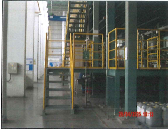
ภาพที่ 2.2-20 ฝักบัวล้างตัวและอ่างล้างตาฉุกเฉิน
